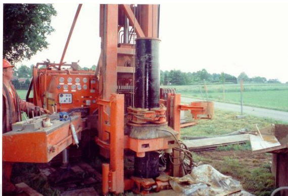
Pulsboring in uitvoering.
