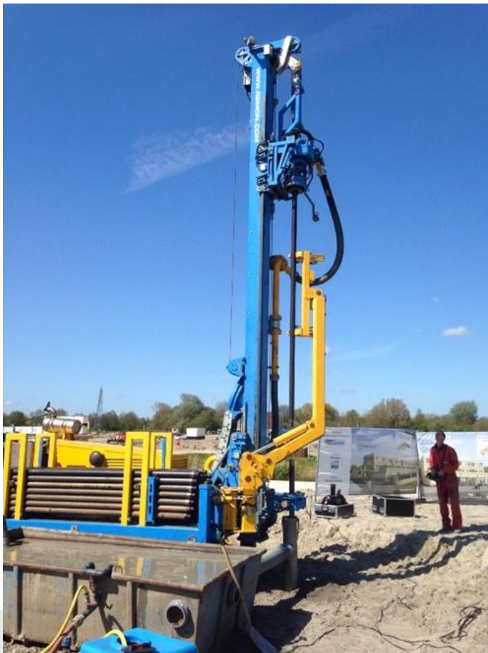
Boring in uitvoering.
