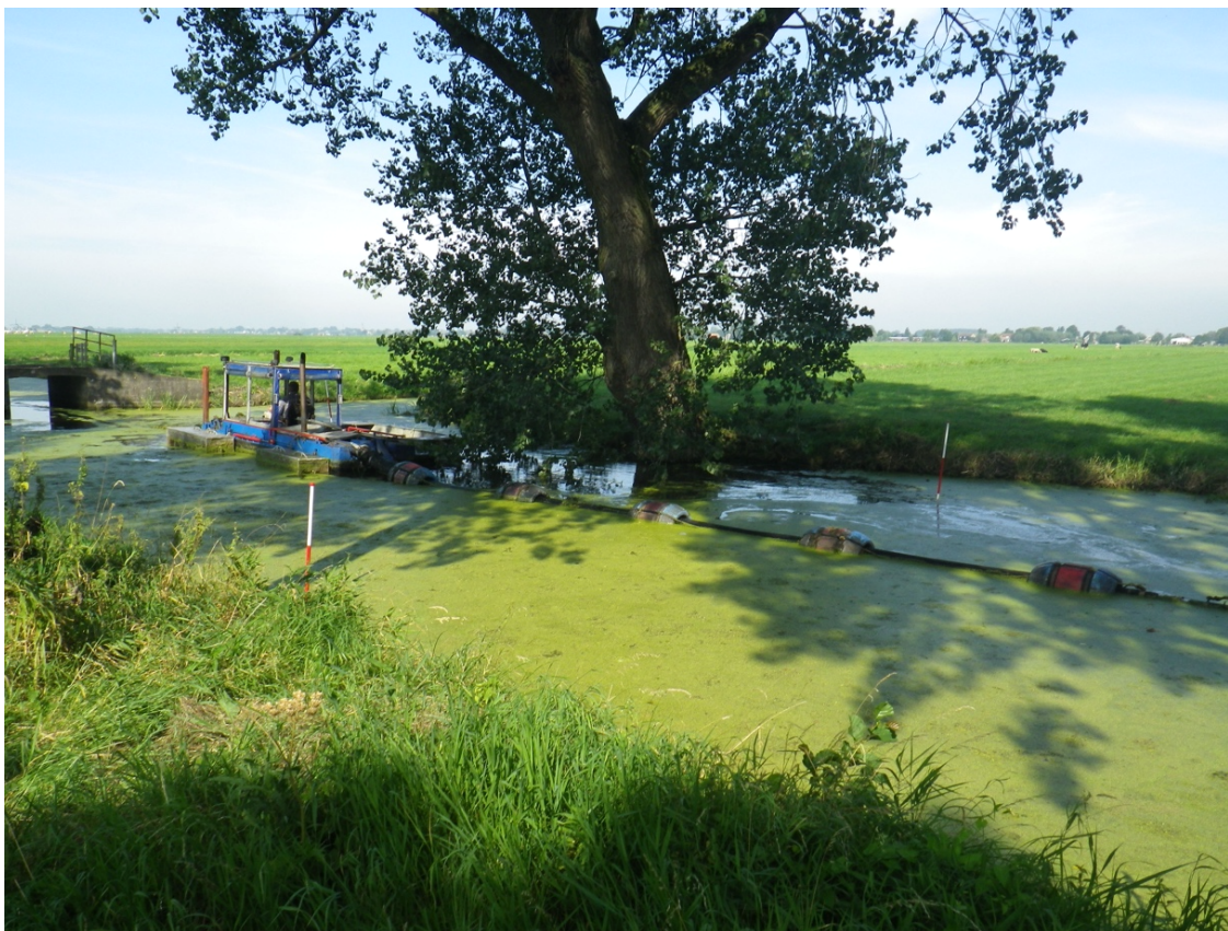
Afbeelding 2. Baggeren met cutterzuiger in veenweidegebied
