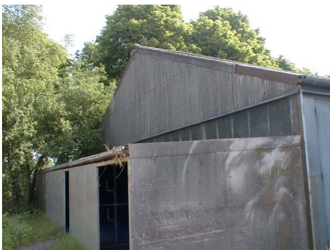
Foto: Asbestbeplating van een schuur
