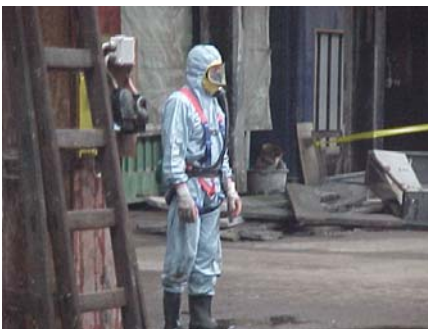
Foto: Beschermende kleding bij verwijdering van asbest
