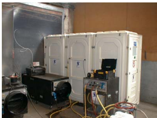
Foto: Onderdrukcabine bij asbestsanering
