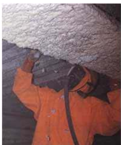
Foto Verwijderen van spuit- asbest in beschermen- de kleding
